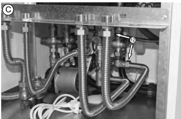
Abb./Fig. 7: Montage Wellrohr Heizungsvorlauf
