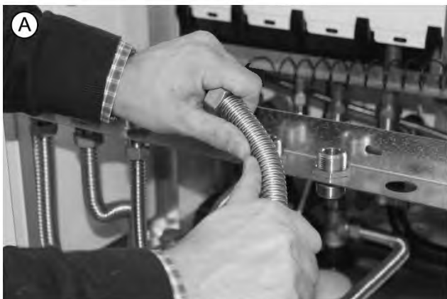
Abb./Fig. 6: Montage Wellrohr Trinkwarmwasser
