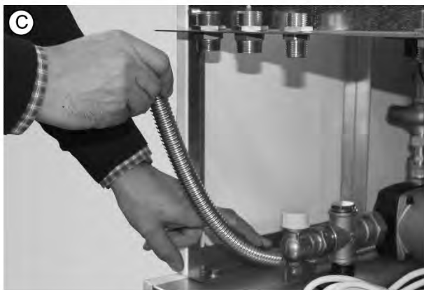
Abb./Fig. 3: Montage Wellrohr Heizungsrücklauf
